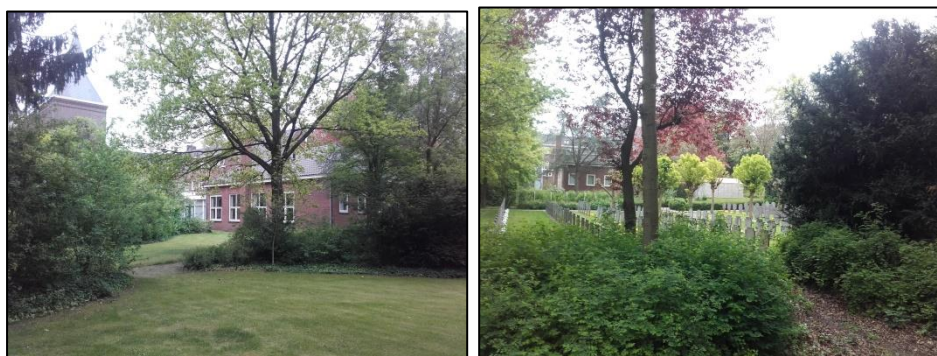
Figuur 3.4a (linkerfoto) Zicht op de te slopen aanbouw aan de achterzijde van het kloostergebouw gezien vanaf boorlocatie 14 kijkende in zuidwestelijke richting (d.d. 08-05-2017).
